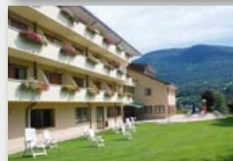
L'Hotel Flora di Ponte Arche
